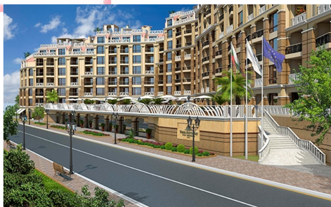
Συγκρότημα Varna Seaside Beach Resort, Varna, Βουλγαρία Κατασκευάστηκε: 2015 Αρχιτέκτονας: Krasimira Christova
