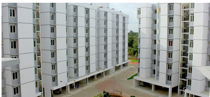
Συγκρότημα Vaibhav, Bhiwadi, Ινδία Κατασκευάστηκε: 2010 Αρχιτέκτονας: Inform Architects
